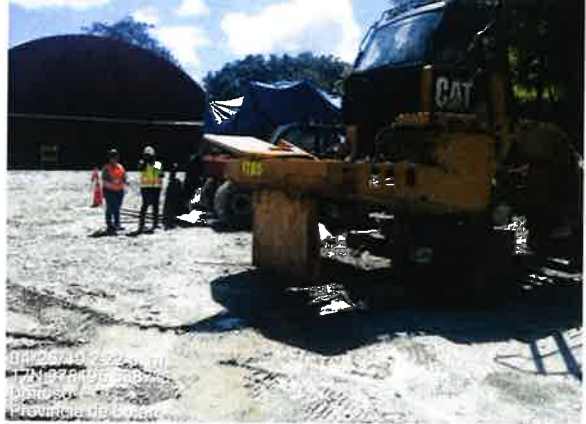
Fig. 1.6. En el patio del taller KALTIRE, se evidencio derrame de hidrocarburo en el suelo, en un equipo pesado dañado y que es utilizado para piezas.
