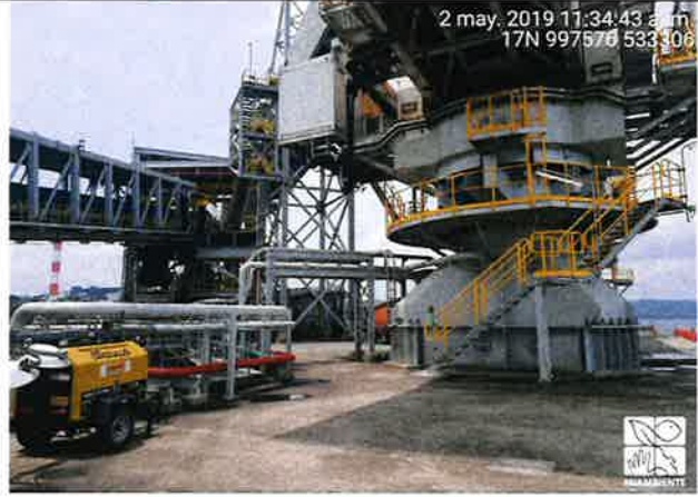
Fig. N° 32.1. Terminal #2 del Puerto, área de embarque de concentrado de cobre y desembarque de carbón.
