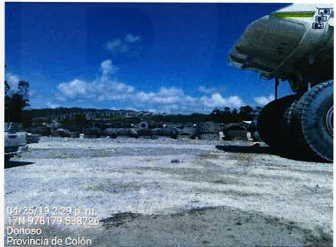
Fig. 10.7. En el patio del taller ULTRACLAS-HDV, se pudo evidenciar gran cantidad de llantas a la intemperie, sin lona para cubrirlas del agua y así evitar la proliferación de vectores nocivos a la salud.
